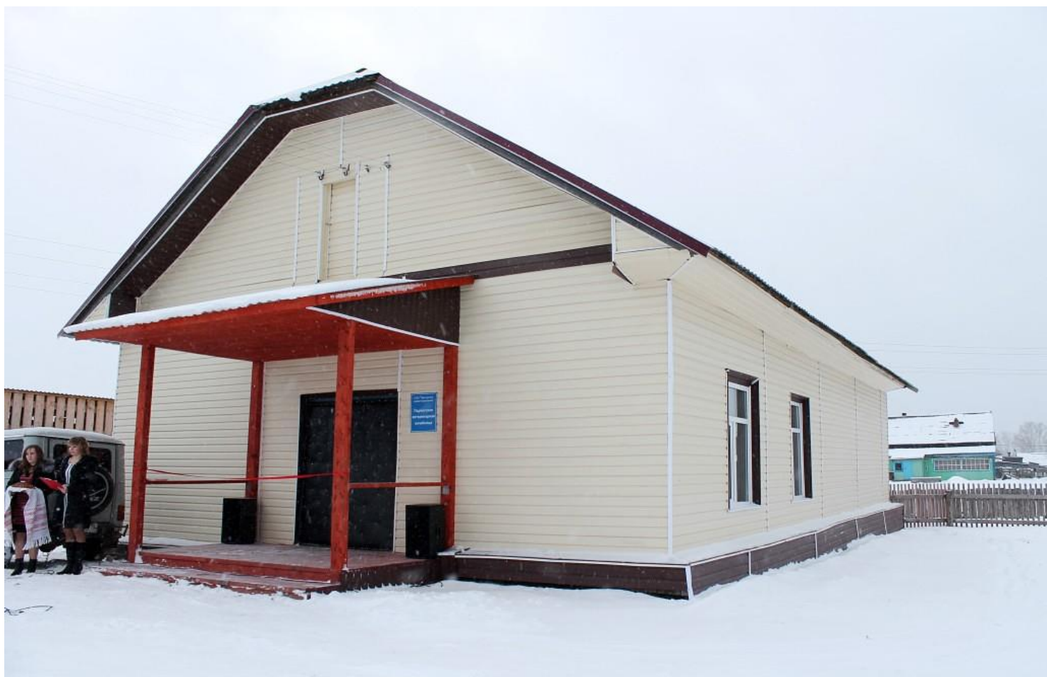
Здание ветучастка после капитального ремонта
